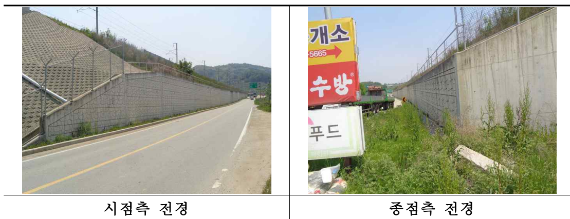
<그림 4.2.2> 역T형 옹벽 현황
