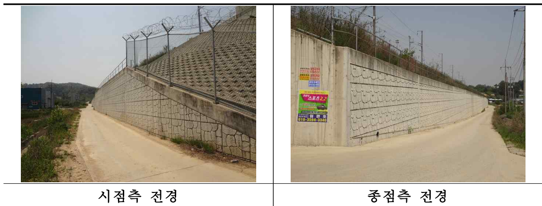
<그림 4.1.2> 역T형 옹벽 현황
